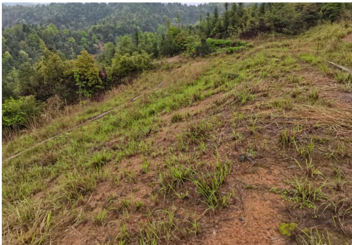
图 2-5 堆积坝下游坝坡
