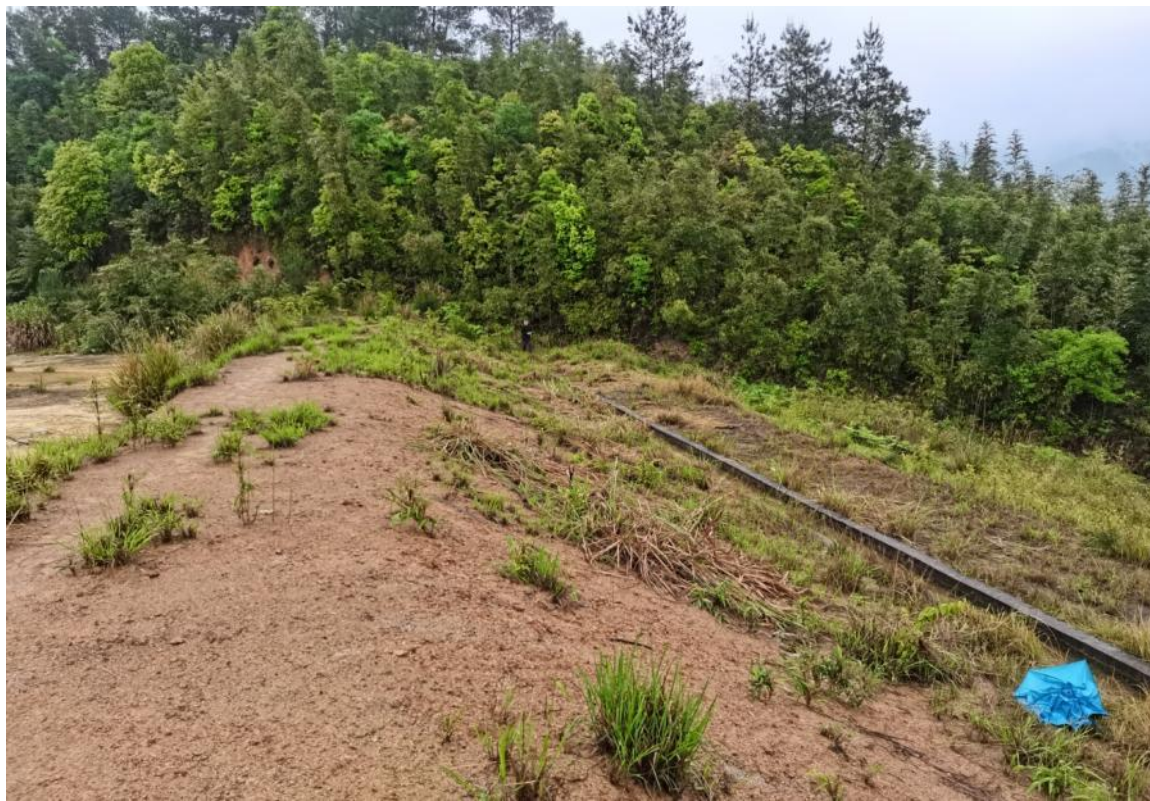
图 2-4 尾矿坝现状坝顶
