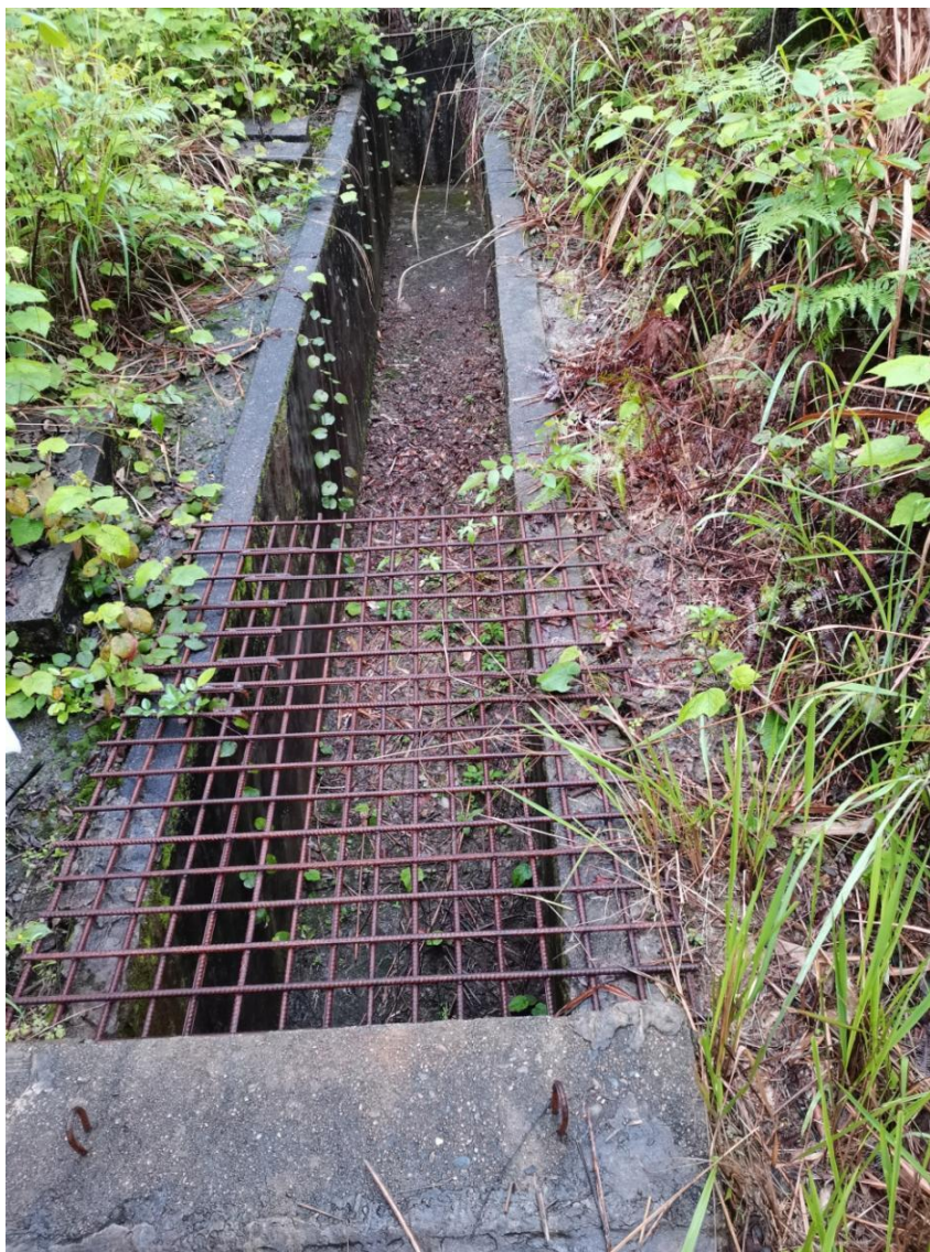
图 2-7 排水斜槽进水口
