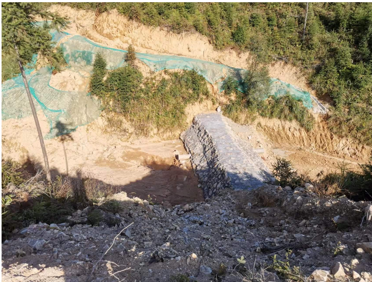
排土场挡土坝及排土场截水沟
