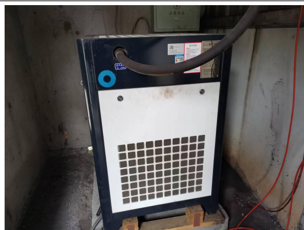
螺杆式空气压缩机
