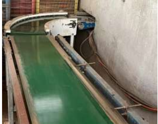
29 号配装封一体机传送带已设“7 字型”
