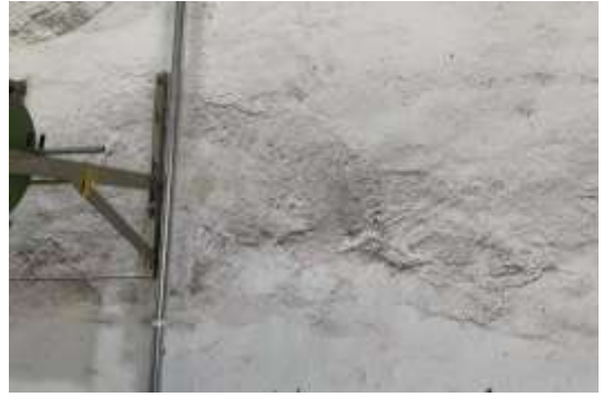
10 号结鞭封装一体机电气线路已穿镀锌管敷设
