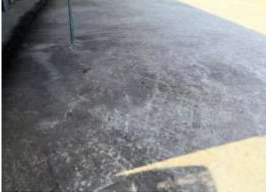
厂区排水沟应完善
