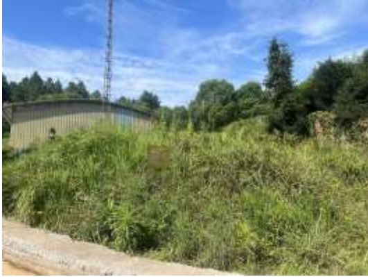
29 号配装封一体机未清理防火隔离带
