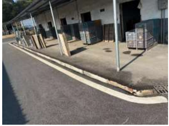
厂区排水沟已完善
